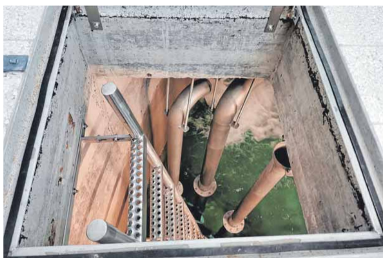
Blick in den Hochbehälter am Wasserturm. Gerade wird er befüllt. Der Pegel steht immer zwischen 2,50 und 3 Metern.
